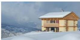
Hotel Maya Boutique Suiza construido con muros de fardos de paja Arquitecto Werner Schmidt (2012)
