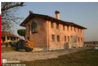
Casa construida con muros de fardos de paja. Arq Stefano Soldati (2006)
